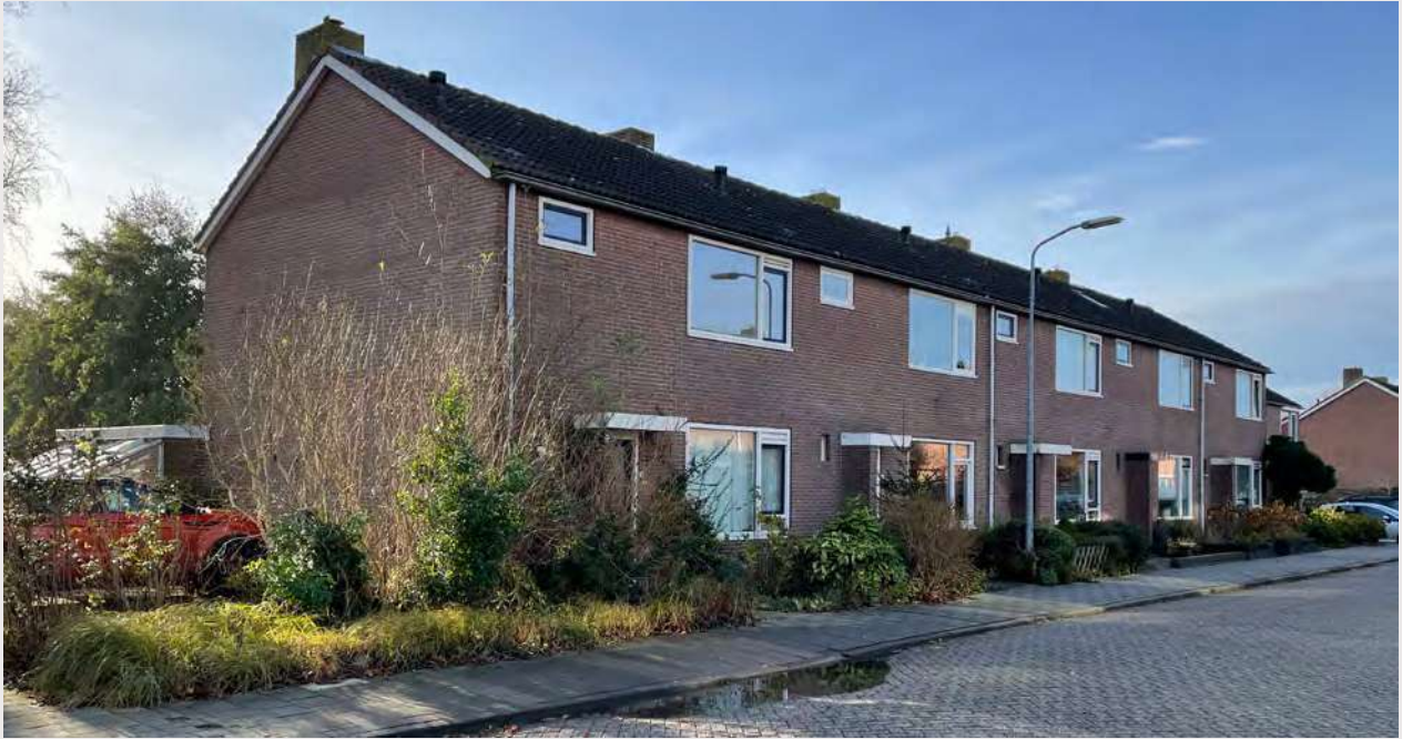
Bernhardweg / Fabiusstraat; Hoge bebouwingsdichtheid, rijwoningen. Twee lagen met kap. Basale en sobere architectuur, repeterende elementen. Geen differentiatie in massa hoofdbouw, kleur en/of materialisering
